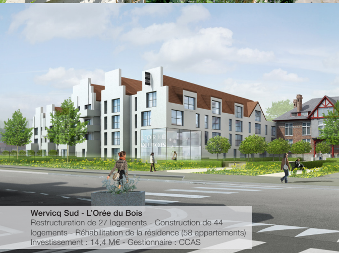
Lille - Cité Menu 19 logements individuels locatifs réhabilités Investissement : 2,1 M€
