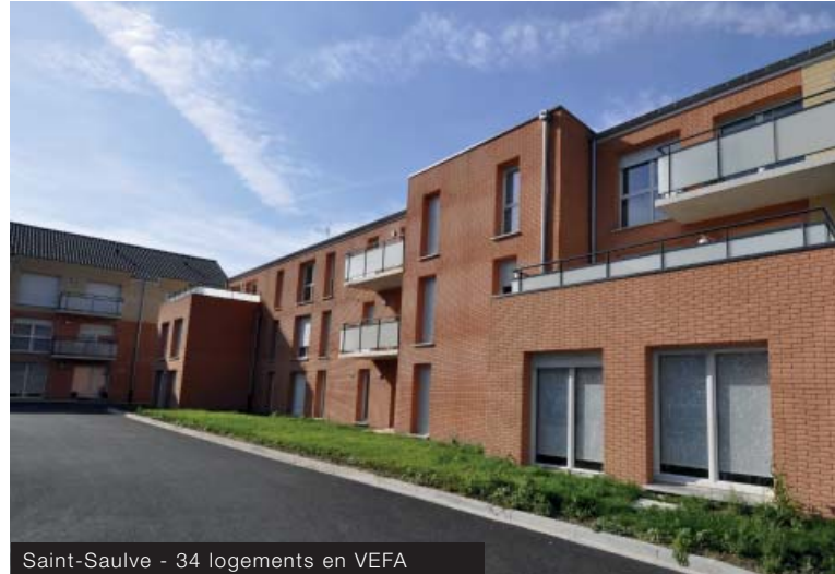
Saint-Saulve - 34 logements en VEFA
