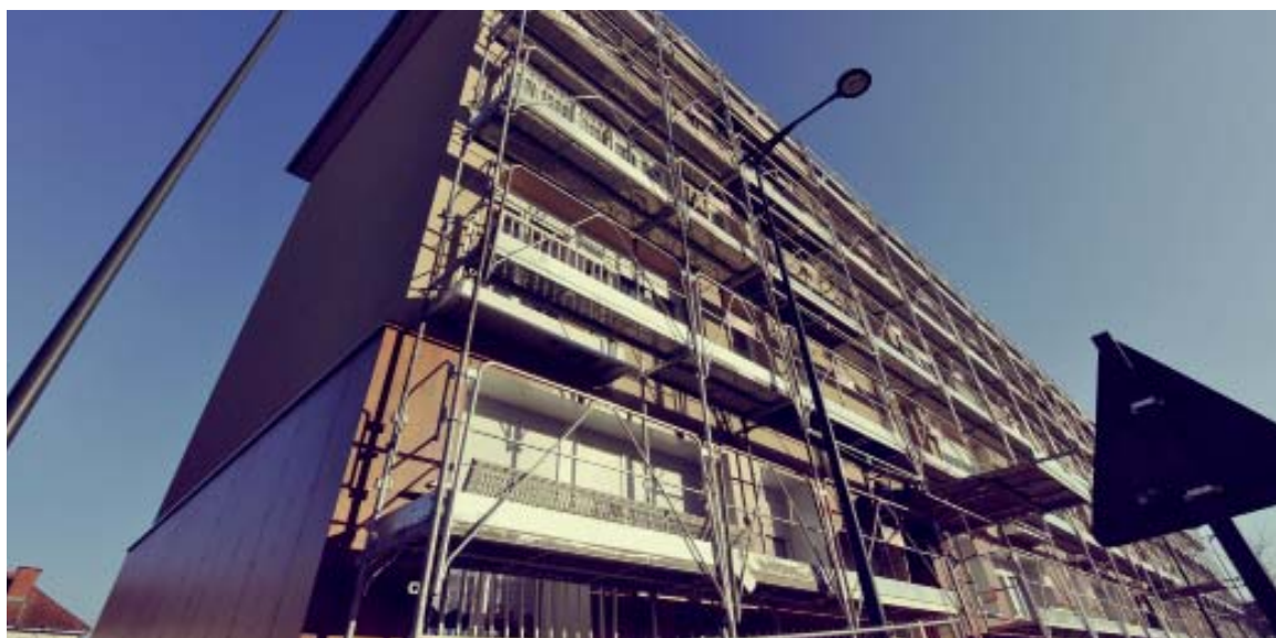
Réhabilitation thermique de la résidence Peltriset - Avesnes sur Helpe
